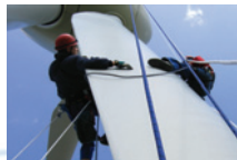
Seilzugangstechnik zur Inspektion der Rotorblätter Rope Access Technique for Rotor Blade Inspections
